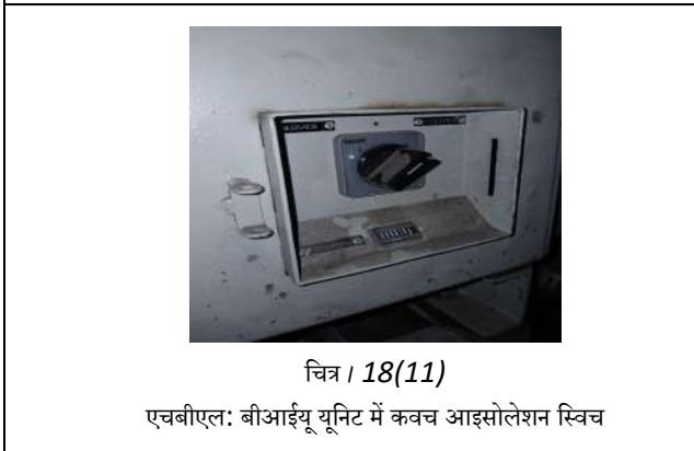
कर्नेक्स: Pn.panel पर कवच आइसोलेशनस्विच
